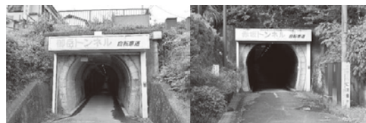
御岳トンネル
